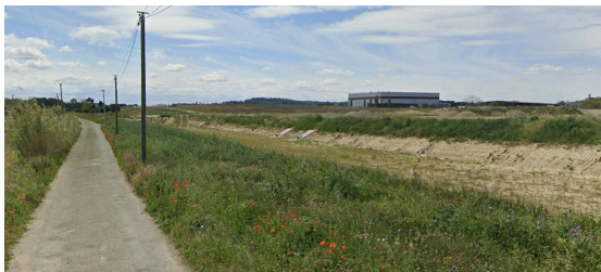
L'aménagement des espaces de rétention - état d'avancement des travaux en avril 2024
