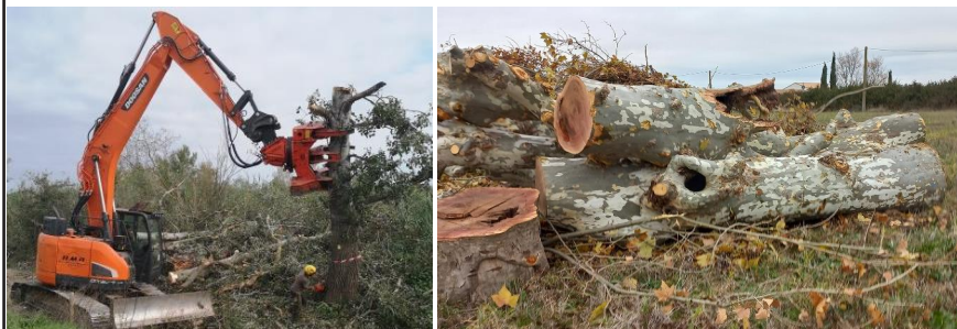
Exemples des modalités d'intervention pour l'abattage : à gauche, coupe d'un arbre sur un large tronçon ; à droite : maintien des grumes au sol, cavités vers le haut, après la coupe – CBE, 2022
