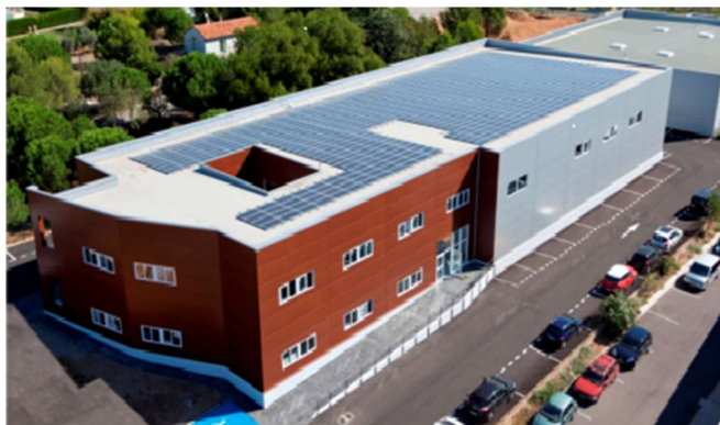
PV sur toiture plate - Photo DR
