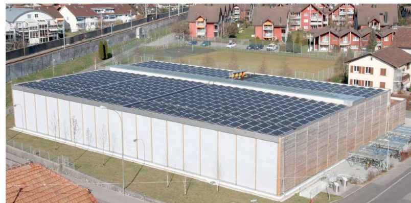
Bâtiment de stockage à toiture plate recouverte de PV - Photo DR
