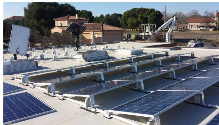
Bâtiment de bureaux – toiture plate (34) - Photo DR
