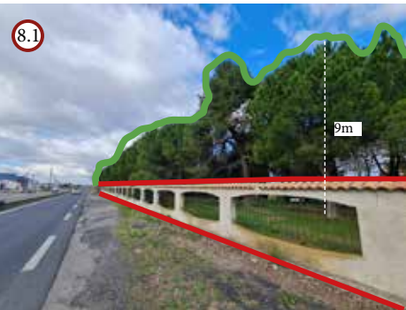
Absence de haie et visibilité du bâtiment
